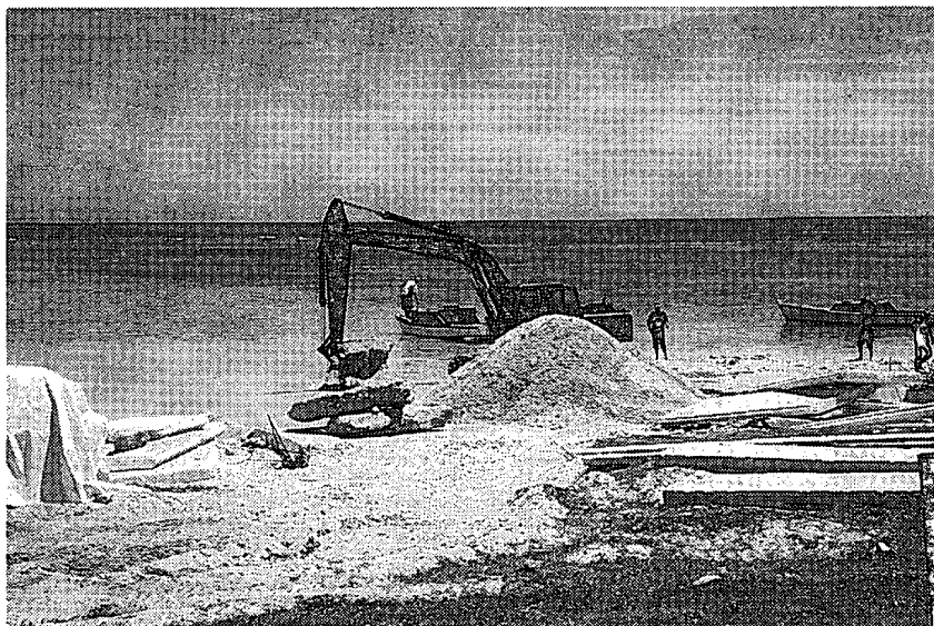
写真11 建設中の埠頭
