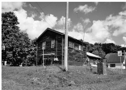
今は廃墟となっている旧・曙分館の建物（筆者撮影）
