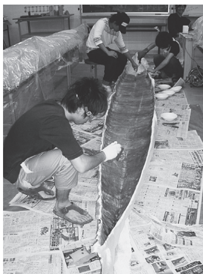
写真－11 エポキシ樹脂塗布
