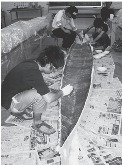
写真-11 エポキシ樹脂塗布
