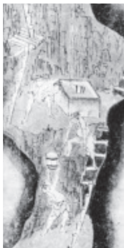
図-1 「手繰り」水替作業現場
