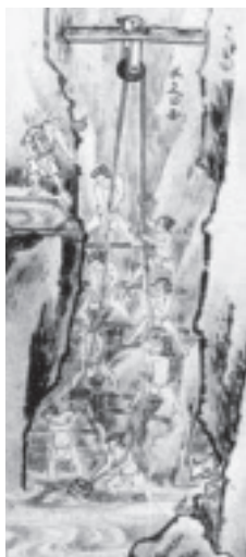
図-2 「車引き」水替作業現場
