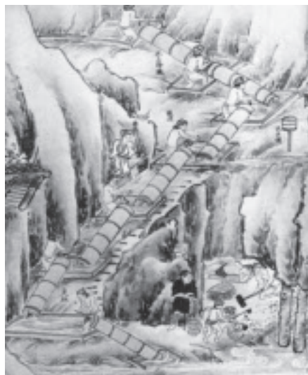
図-3 「水上輪」による水替作業現場
