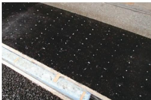
写真-2 凍結防止剤散布状況
