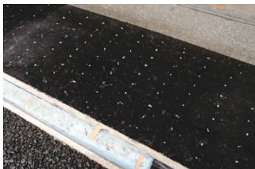
写真-2 凍結防止剤散布状況
