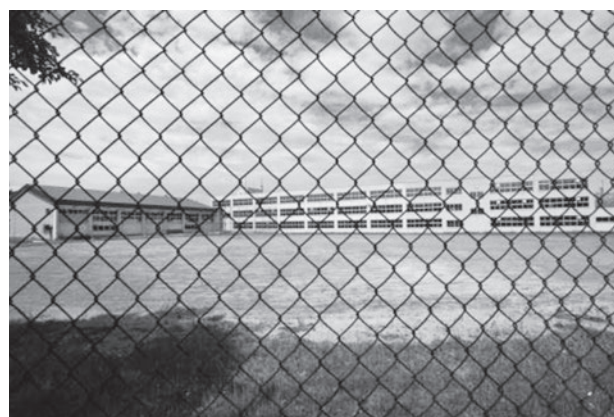
もみじ台小学校 グラウンド側からの全景
