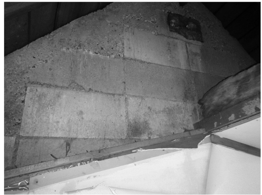
写真7 中2階妻壁の状況
