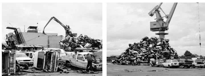
図 9 ティラワ工場で解体の様子
