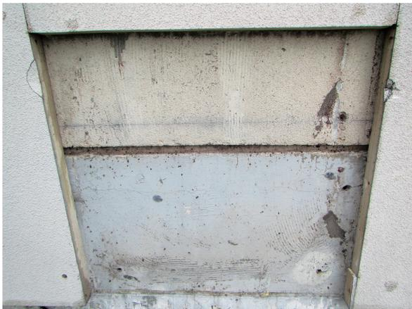
図6 西面外断熱材撤去後の状況(建築物A). 撤去後表面が全体的に湿っていた。
