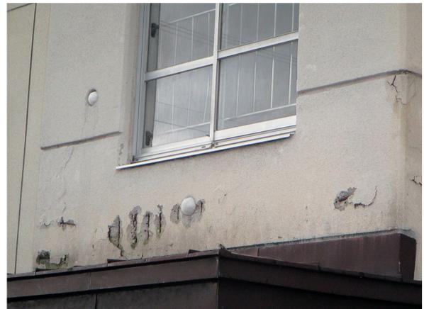
図5 階段室外壁の変状(建築物A)
