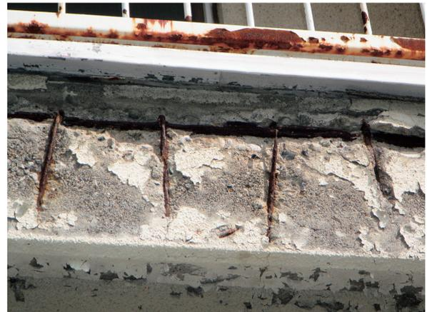
図4 バルコニー先端部の変状(建築物A)<sup>7)</sup>
