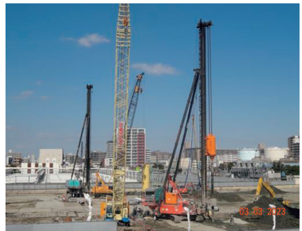
図5 クローラークレーンと杭打機
