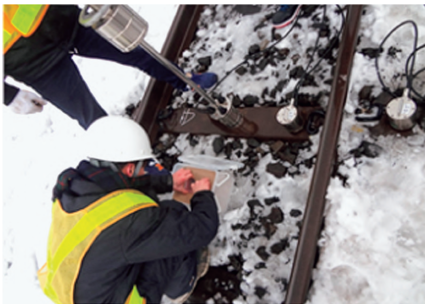
図 5 小型 FWD による載荷変位測定
